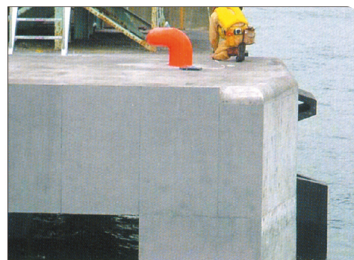
■施工例/ドルフィンへの適用
