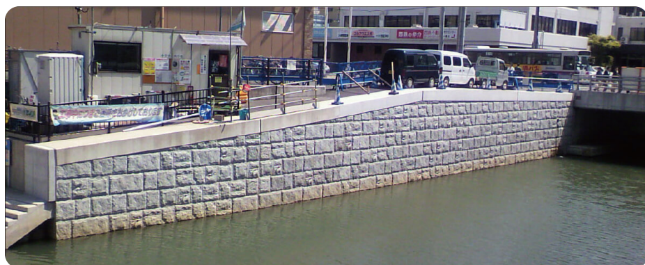
「福岡県」福岡県北九州市役所 砂津川護岸工事
