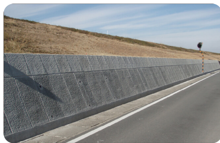
「岐阜県」中部地方整備局木曾川上流河川事務所 長良管内維持補修工事
