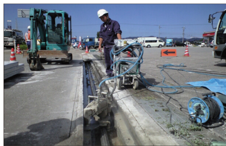
W2Rカッターによる切断
