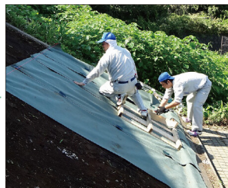
■雑草シート敷設
