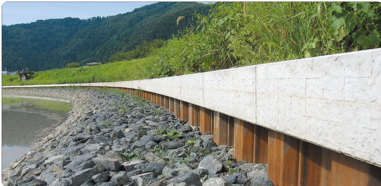
■ 矢板護岸用笠コンブロックは、矢板上部に覆い被せるように設置して、胴込コンクリートを打設することで矢板と笠コンブロックとの一体化が図れます。
