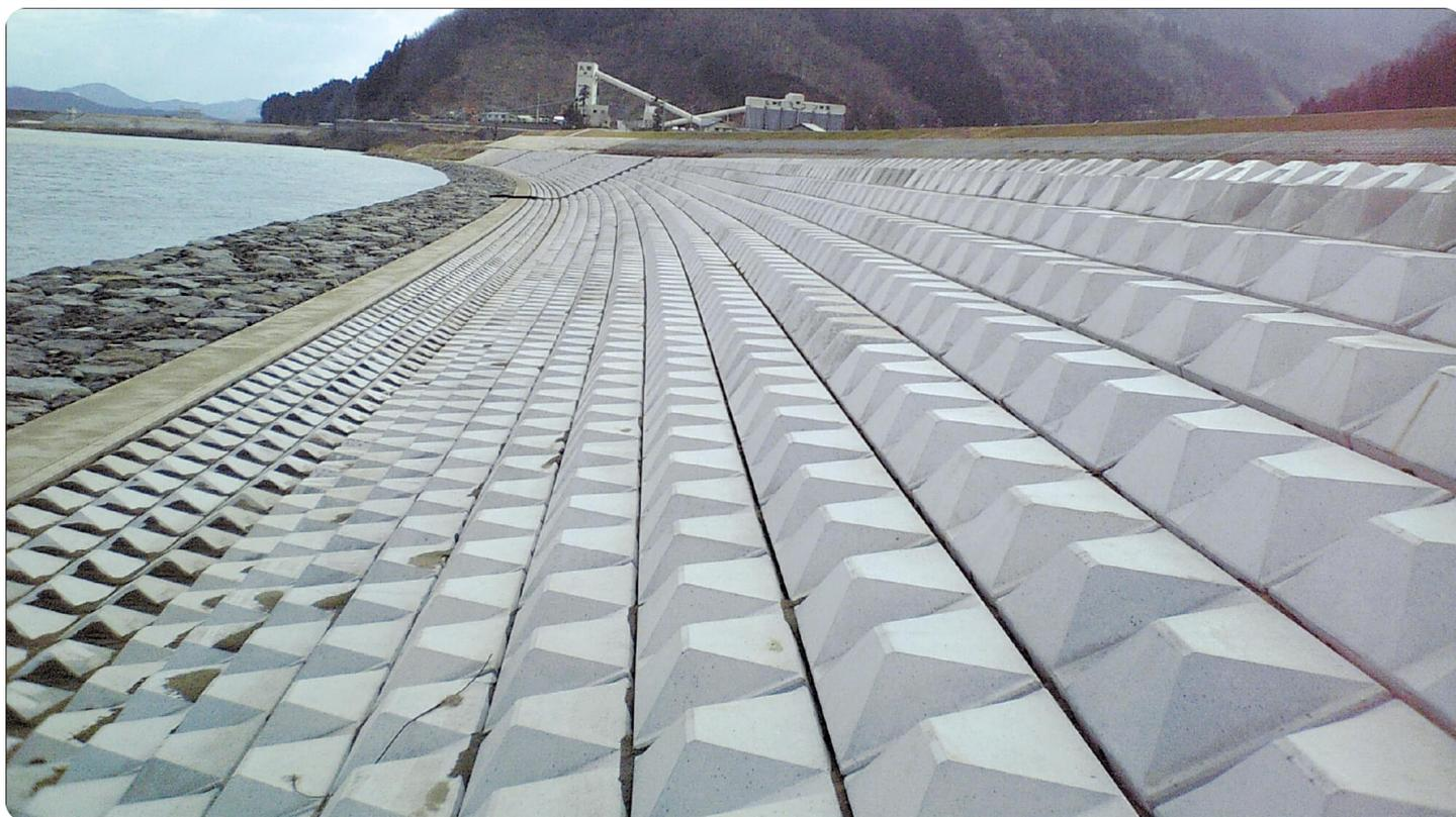
■ ダブルステップは、連結により一体化されることで流水に対して安定した性能を持つ連節ブロックです。
