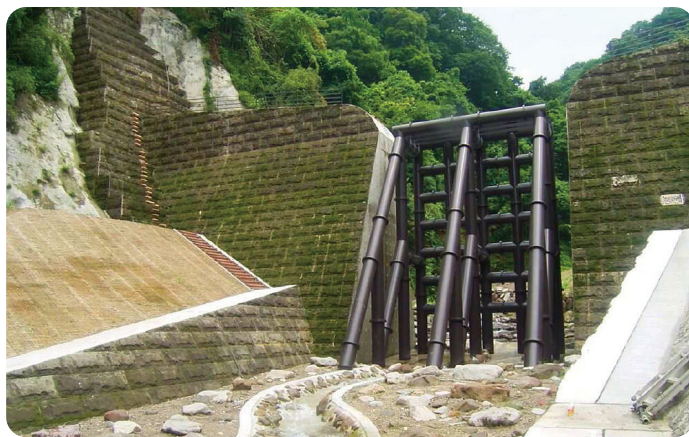
プロテロックメイク (残存型) 施工例
