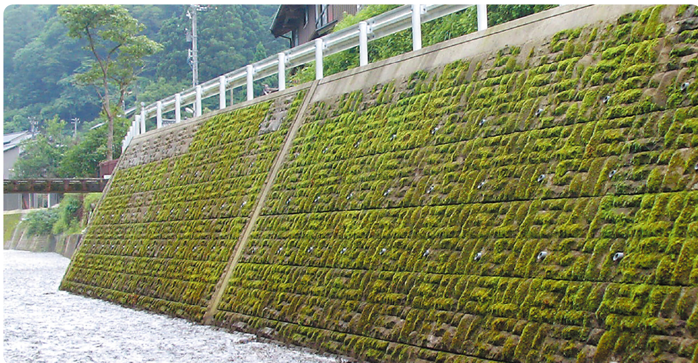
施工後1年10ヶ月経過
