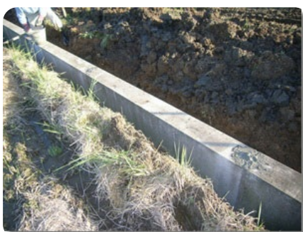
埋め戻し状況
