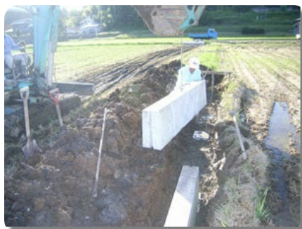
④据付状況
