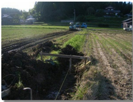
②床掘・丁張状況
