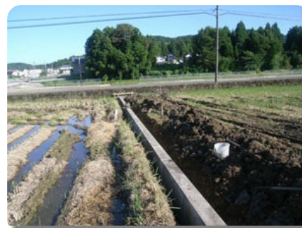
⑥据付完了
