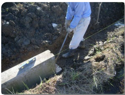
⑤据付状況 微調整
