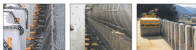
■ 砕石型枠変形前 ■ 砕石型枠変形後 ■ 壁面近傍転圧状況
