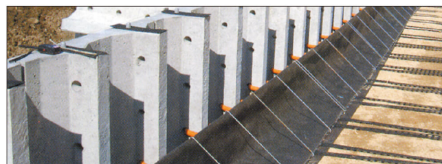
■ 締り前の背面施工状況
