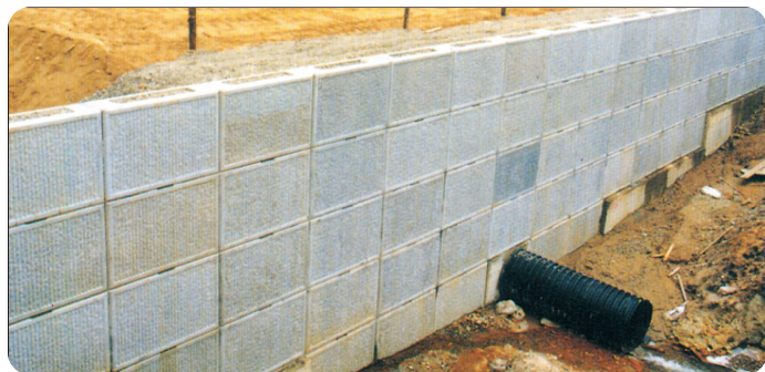
重力式擁壁タイプ施工例
