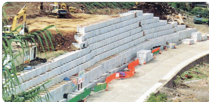
緑化擁壁タイプ施工例
