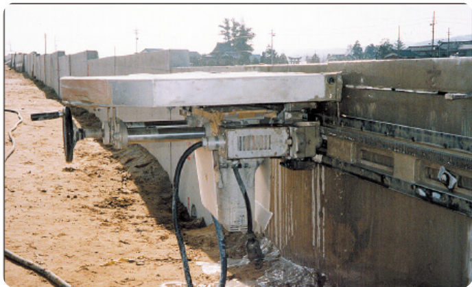
施工中／擁壁内面より専用カッターにてカットします。
