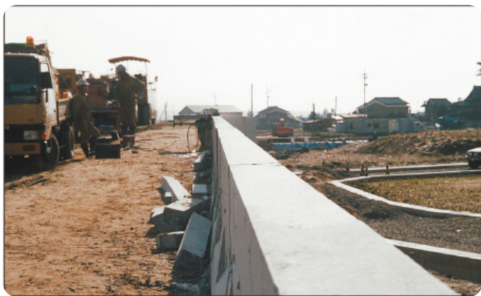
施工直後の天端カット状況
