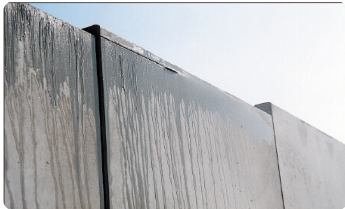
施工中／擁壁外面
