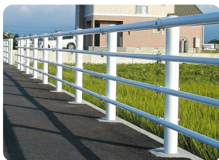
無駄のないスッキリした歩道
