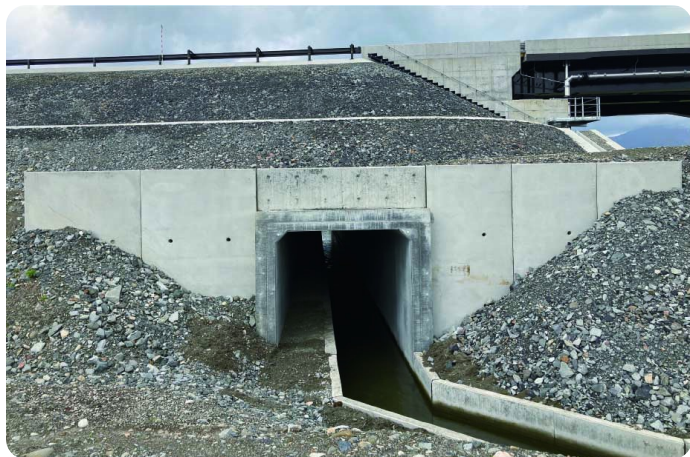
■大型L型擁壁
