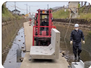
L形水路（新又千保連絡水路）
