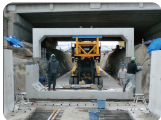
ボックスカルバート（海尻川排水路）
