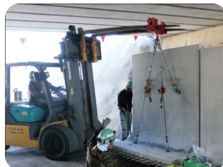
橋梁下への施工（海尻川排水路）
