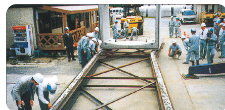
カーブ施工実験風景
