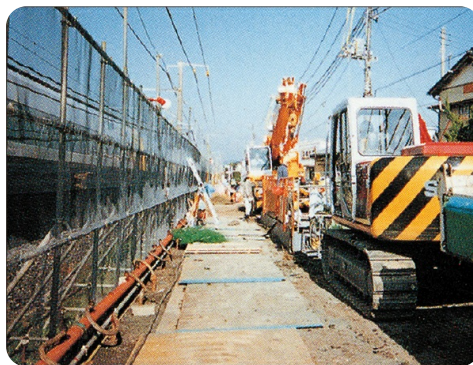
鉄道近接施工
