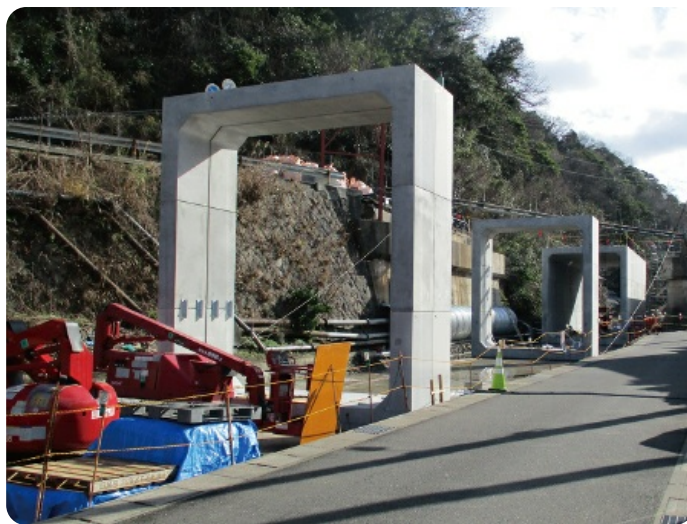
施工状況写真（横引き工法との併用例）
