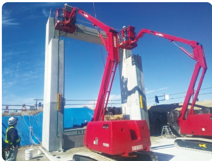
施工状況写真
