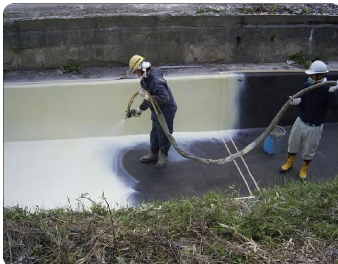
**作業性** 厚膜でもタレが発生せず、速硬化が可能です。
