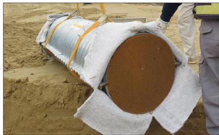
■吸出防止材を土柱ブロックに固定する。
