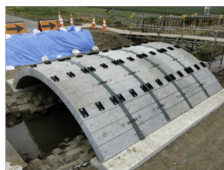
アーチリング施工完了
