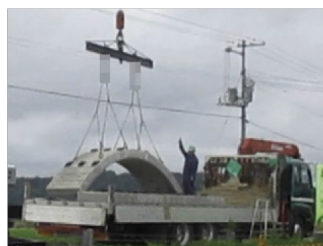
アーチリング吊上げ
