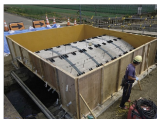
バックフィル用型枠組立完了
