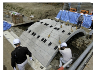
アーチリング据付け
