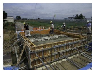
バックフィルコンクリート打込み
