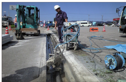
W2Rカッターによる切断
