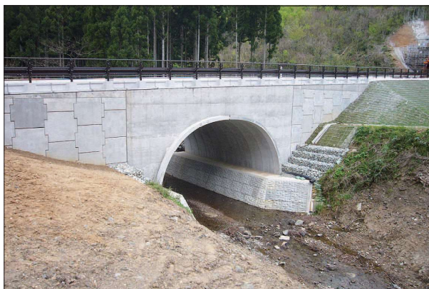
■ 石川県一般県道荒木田原町線 施工延長14m (11,000 x 4,800)
