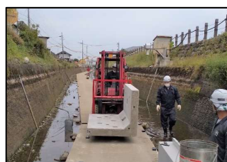
■ L形水路 （新又千保連絡水路）
