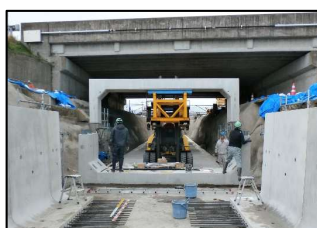
■ ボックスカルバート （海尻川排水路）
